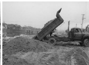
荒井川の埋め立て工事の様子
